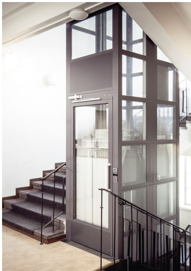
Šachta výtahu KONE ProSpace™ je samonosná, takže nijak nezatěžuje budovu mimo síly, které jsou přenášeny do prohlubně.
